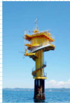
白浜海象観測所・観測塔
