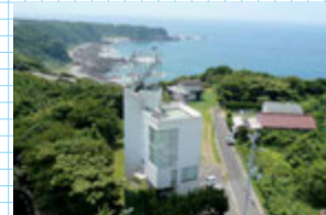
潮岬風力実験所・本館
