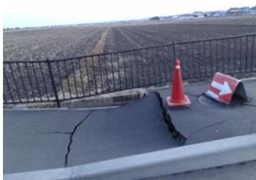
各所で路面が陥没したり、マンホールが浮き上がり、橋の部分で段差が発生している。
