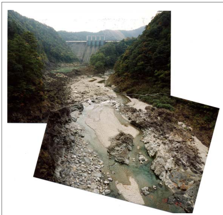
写真4 風屋ダムとその下流（風屋大橋から望む）。ダム下流右手から支川滝川が合流。ただし流砂は少なく、岩盤河床の状態に近い。2000年11月14日撮影
