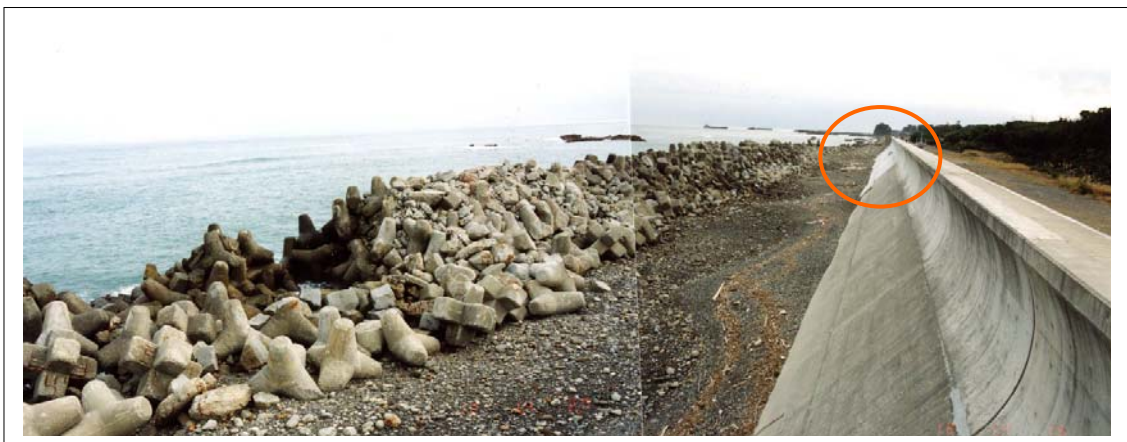
写真1 七里御浜の井田海岸から鶴殿港方面を臨む。前浜の著しい侵食。防波堤の白い部分は1997年の台風による風浪で倒壊し、その後復旧された箇所。2000年11月12日撮影。
