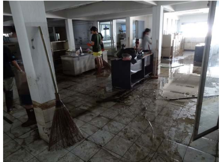
(b) 水資源工学科の建物内
