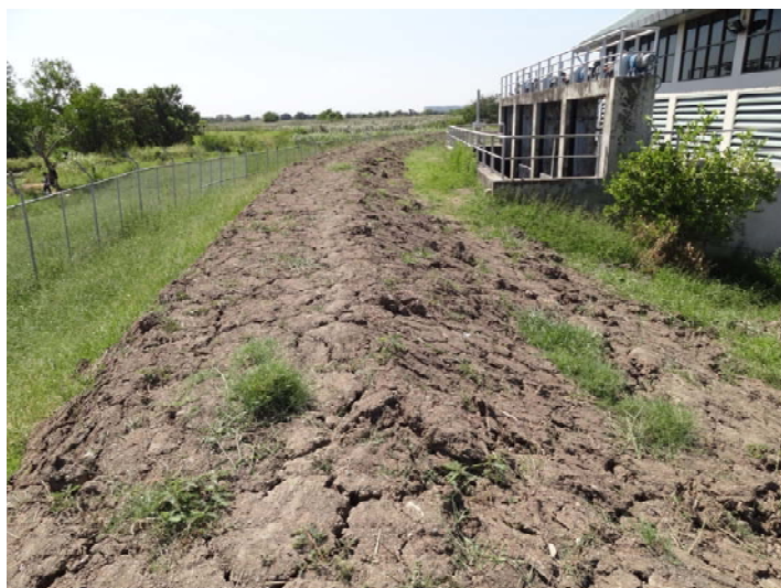
(a) 嵩上げされた土堤
