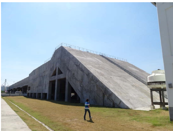
(b) 高架型の排水路
