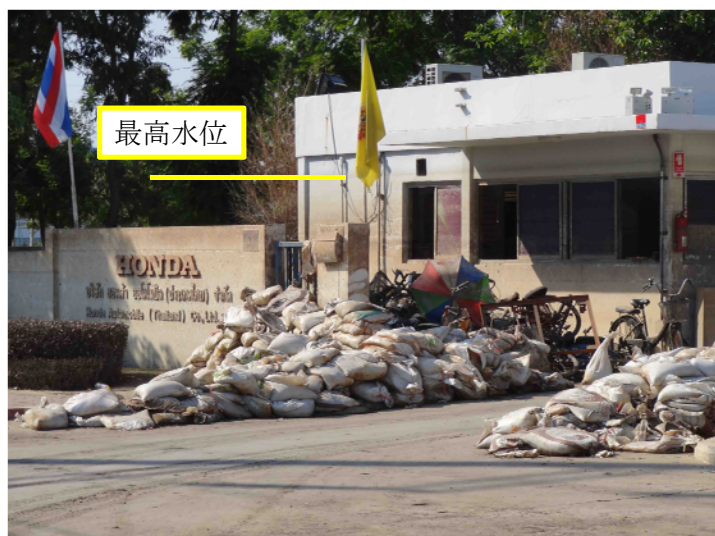
(a) ホンダ自動車の工場
