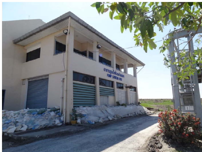
(b) 南東のポンプステーション
