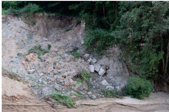
写真-11 沢の左側にある崩壊した駐車場の残存部およびコンクリートブロック
