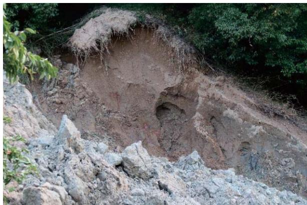
写真-13 下流のため池堤体（左側）における大きな破壊により露出した堤体の内部構造
