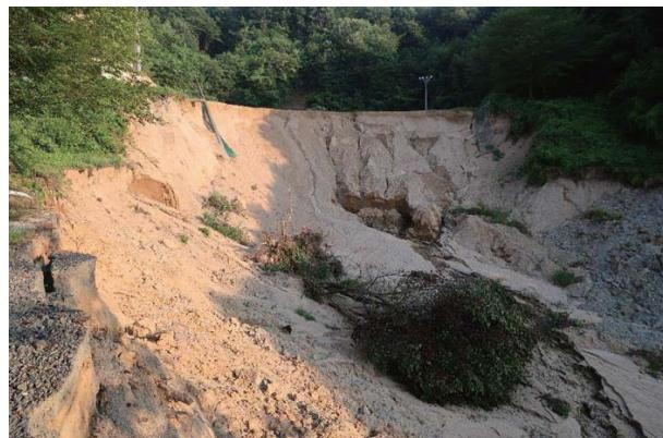
写真-9 グラウンドの下流側から見た様子を示す。末端から湧水が出ている。
