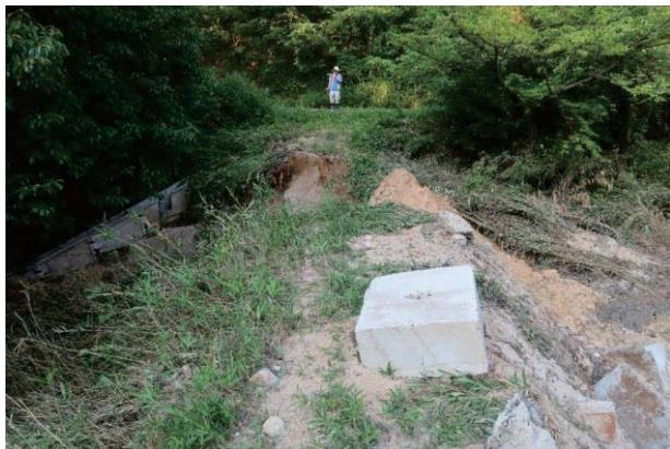
写真-12 下流のため池堤体（右側）における小さい破壊及び上流から流下して堆積したコンクリートブロック
