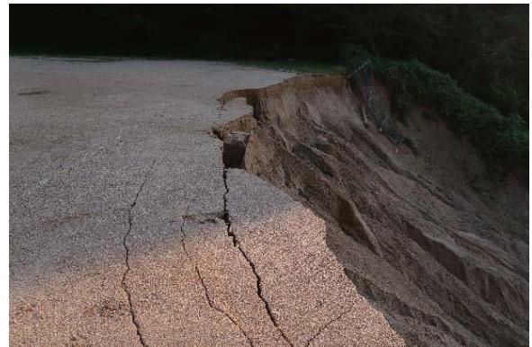
写真-10 グラウンドの表面に形成された開口クラック
