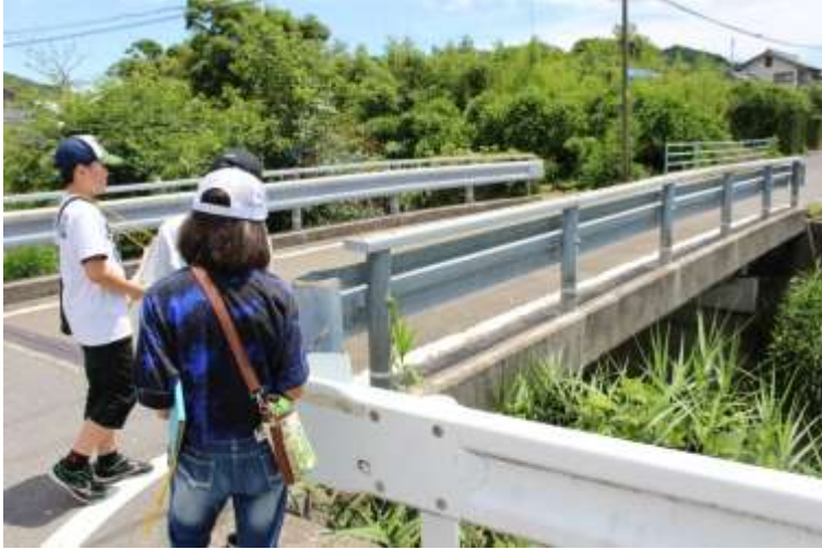
避難ルート上にある橋の耐震化
