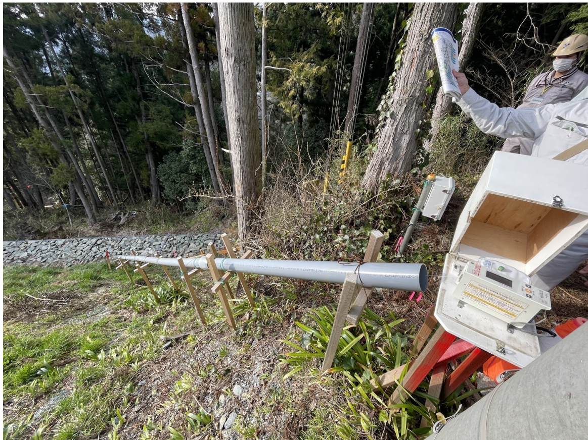
伸縮計による観測（ミリ～マイクロメートル級精度） ・温度変化に強い合金ワイヤの伸び縮みを利用
