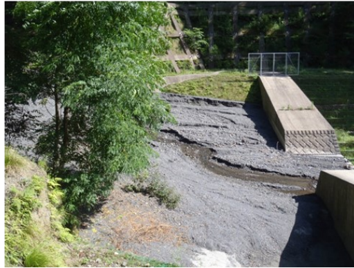
不透過型砂防堰堤（左：下流から望む、右：上流の堆砂状況）
