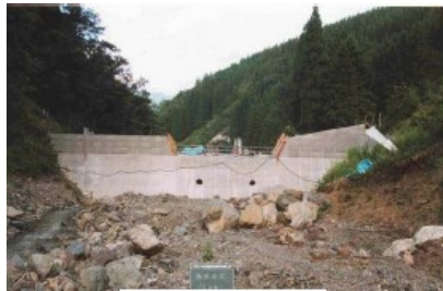
土石流 捕捉前
