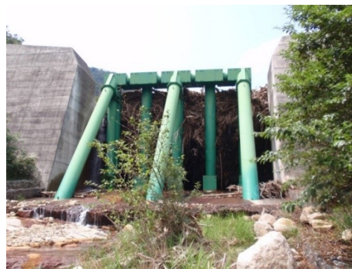
閉塞型の透過型砂防堰堤（鋼製スリットの左：格子型、右：I型スリット）
