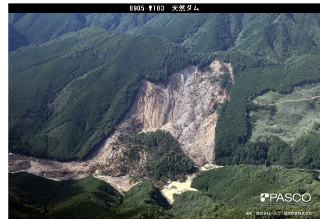
2011年紀伊半島、田辺市熊野の深層崩壊 (撮影：株式会社パスコ)
