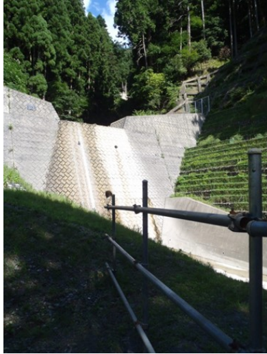
不透過型砂防堰堤（左：下流から望む、右：上流の堆砂状況）
