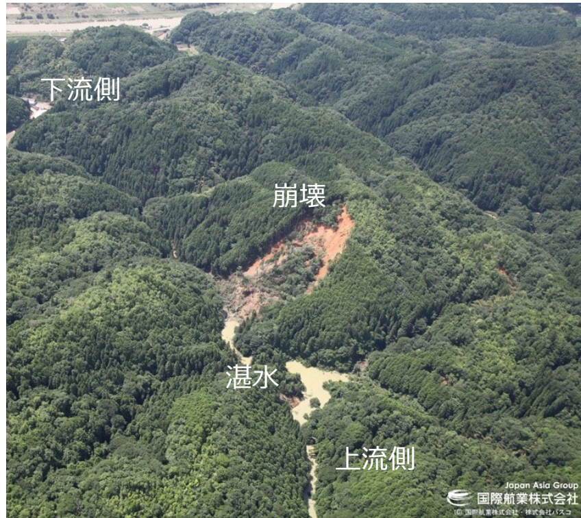
谷河川河道閉塞状況 (出典：国際航業株式会社)
