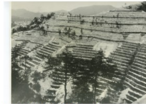
工事着手直後の状況（大正3年）
