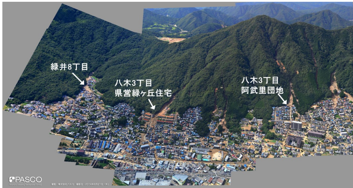
2014年8月に広島県で発生した土砂災害（株式会社パスコ 撮影）
