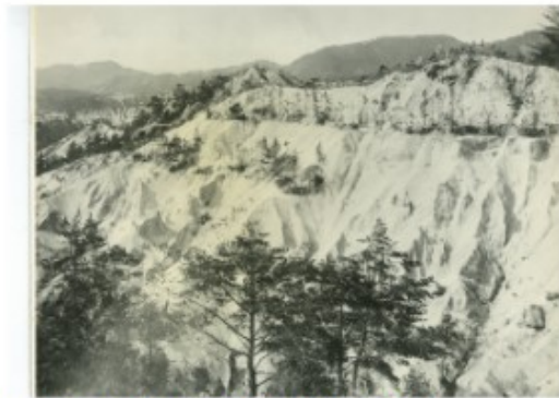
工事着手前の荒廃状況（大正2年）
