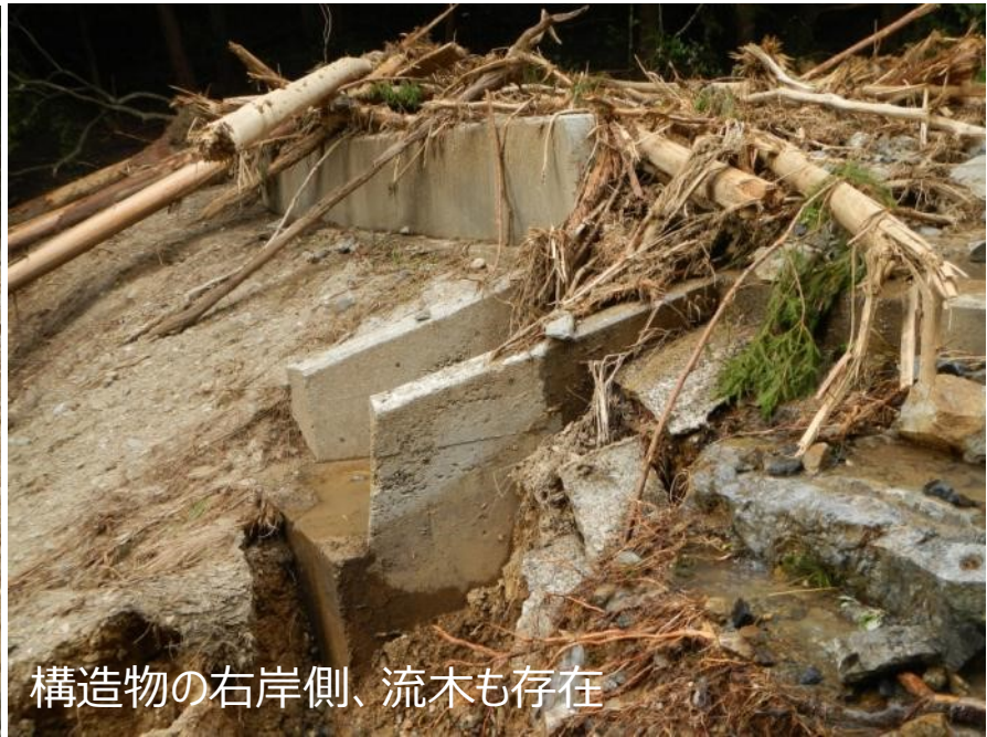
構造物の上流側の堆砂状況
