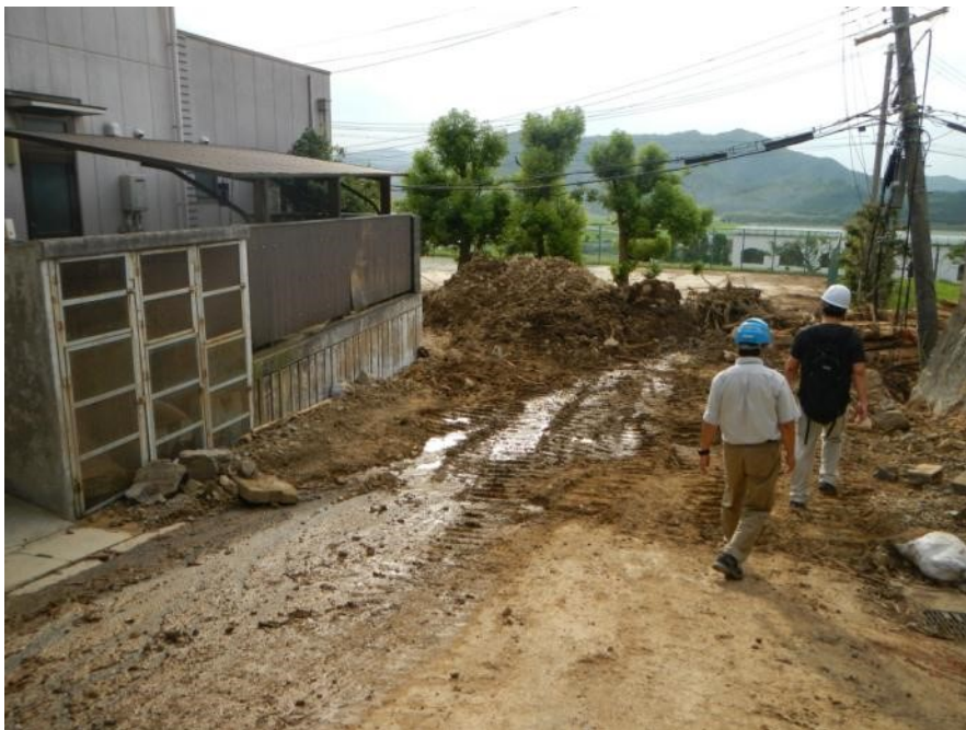
構造物の上流側の堆砂状況
