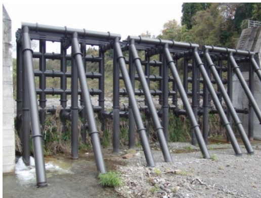
閉塞型の透過型砂防堰堤（鋼製スリットの左：格子型、右：I型スリット）
