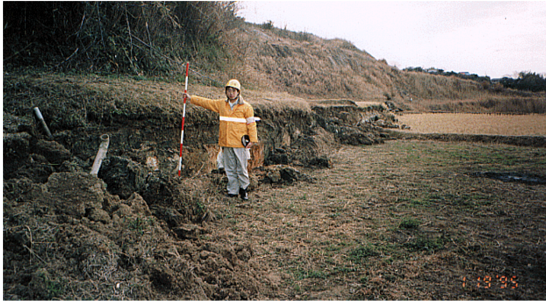
写真-6 北淡町野島平林の断層亀裂
