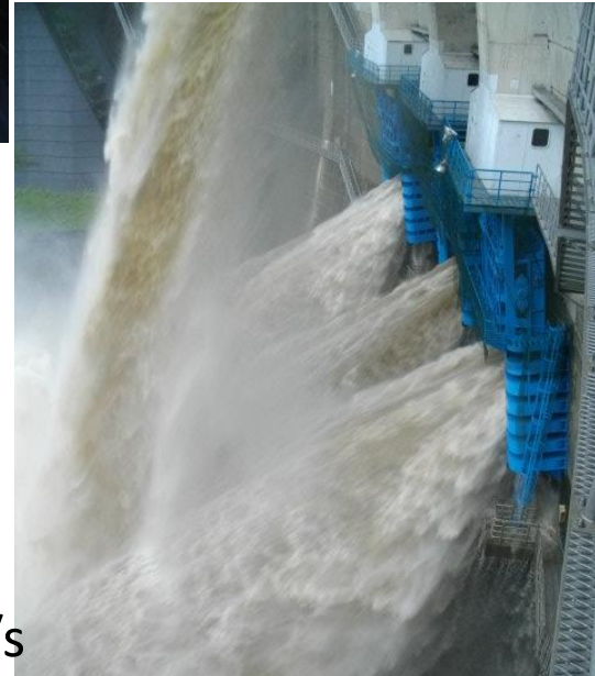
クレストゲートとコンジットゲートを使つての放流
