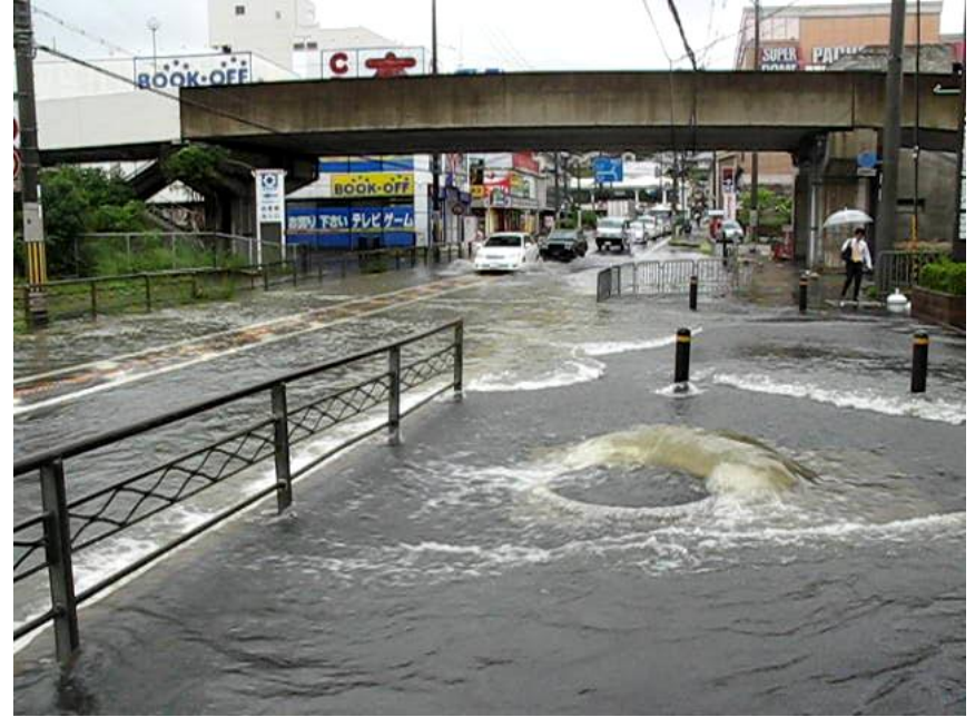
マンホールからの雨水の噴き出し
