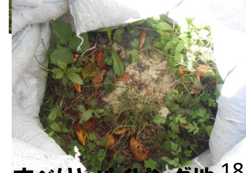
すべりとパイピング地 18 点：釜段工の中の墳砂
