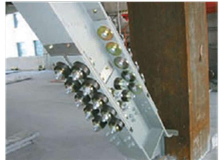
高カボルト摩擦接合滑りダンパ
