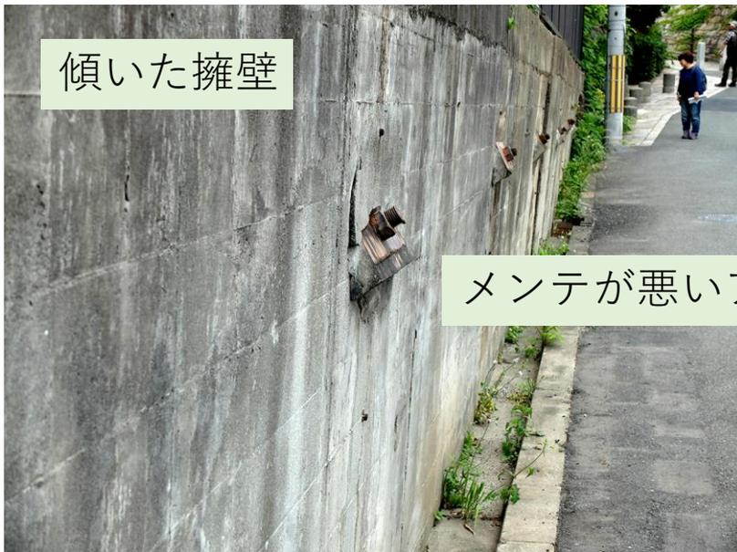
斜面の上部には盛土が張り付いていて、既に沈下している
