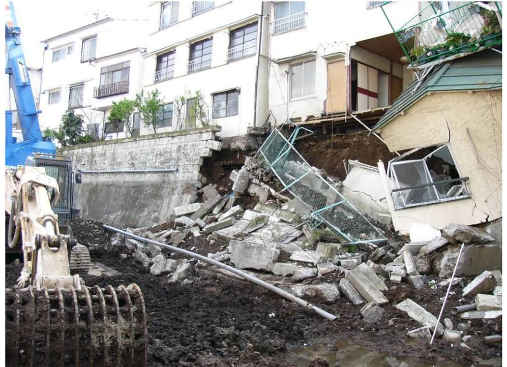
工事のわずかな振動で崩壊
