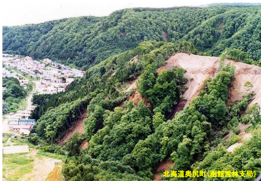
地震によって発生した表層崩壊
