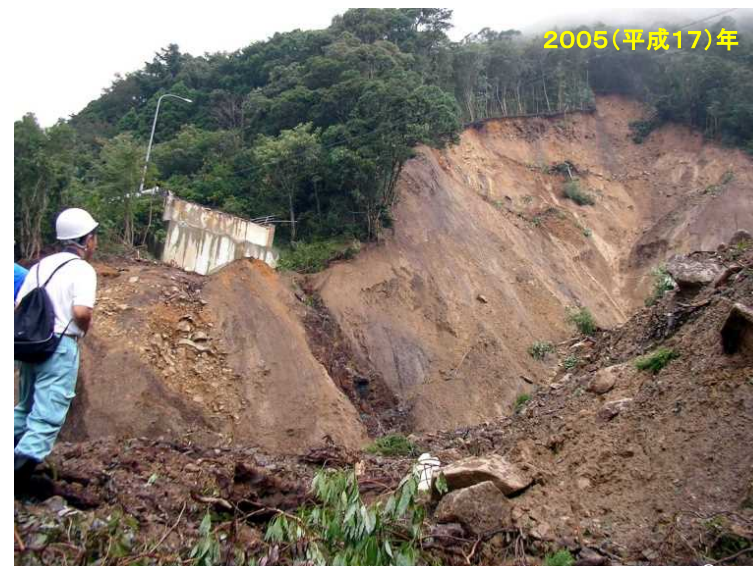
宮崎県日南市国道222号線深層崩壊
