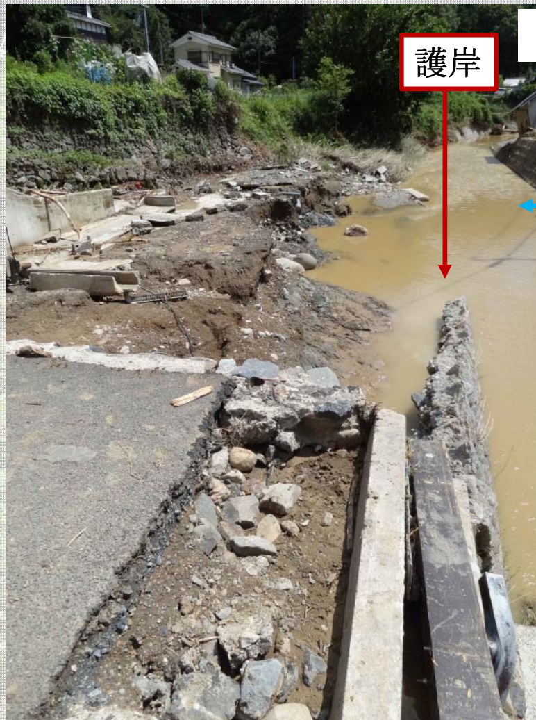
(e) 残存した護岸 (左岸)
