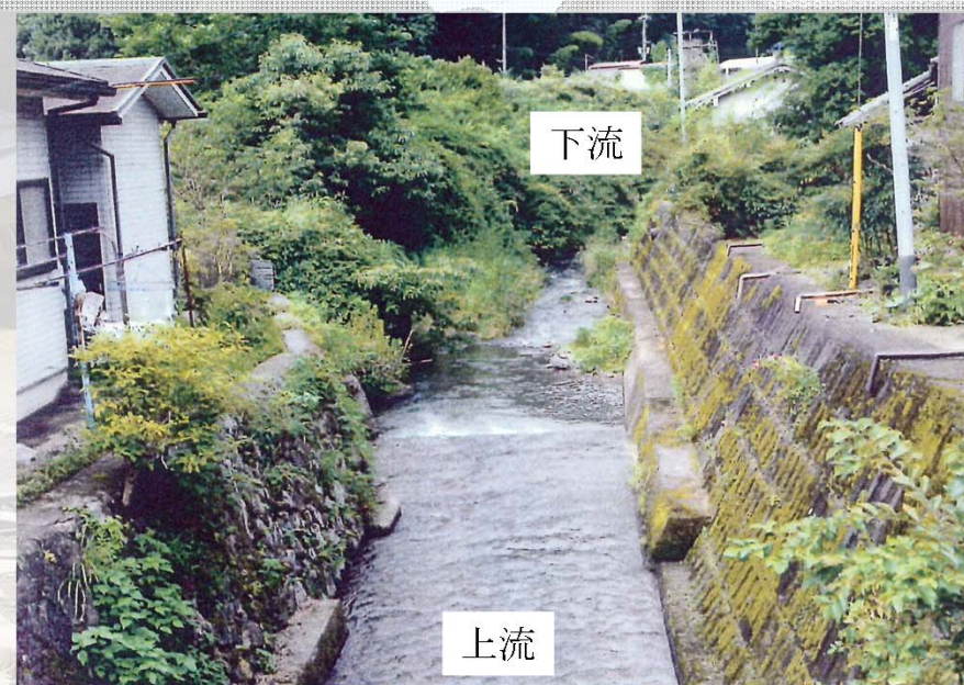
(b) 被災前の前川橋下流の様子
