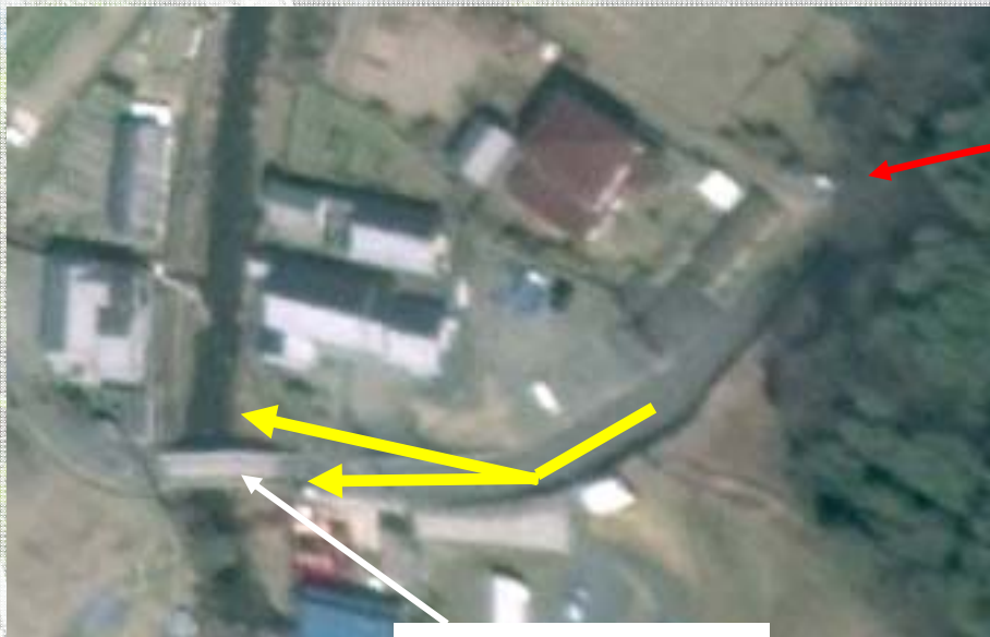
第三志津川橋
