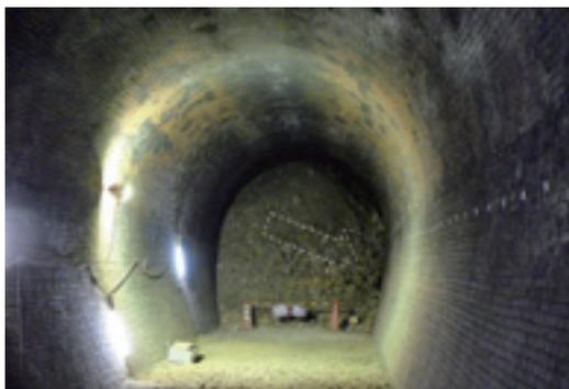
図2 2008年に発見された旧関西本線・亀の瀬トンネルの内部(釜井俊孝教授撮影)。地すべりによって土塊は矢印の方向に移動したと見積られる。
