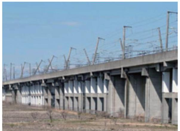
新幹線高架橋上の電化柱の折損・傾斜
