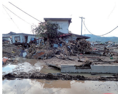
図2 流出した上部構造
