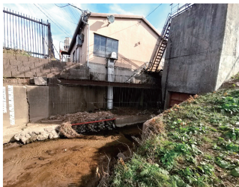
丸森町の水門(右)と内水排除ポンプ(中央) 新川からの逆流を防ぐため水門は閉鎖されたもののポンプの排水が不足 (Herman Musumari氏(M2学生)撮影)
