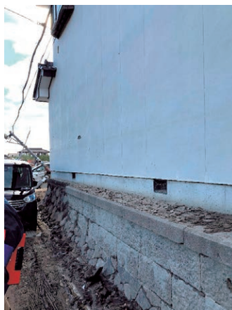
図5 石積みによるかさ上げ
