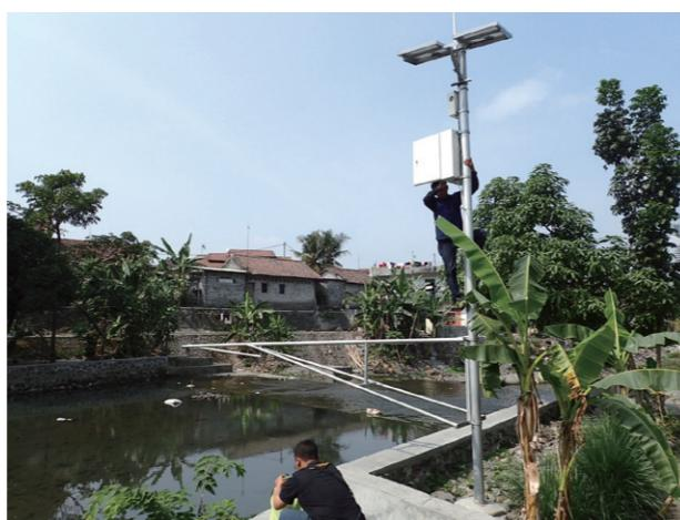
図2-1 ラハール観測装置のメンテナンスの様子。超音波水位計とIPカメラ、データロガー、携帯電話モ뎀、太陽光電池で構成されています。
