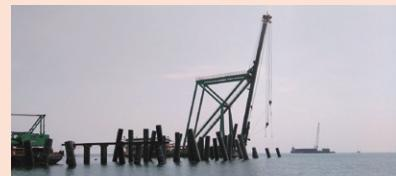
同発電所(石炭荷揚げ用桟橋の杭打設状況)
