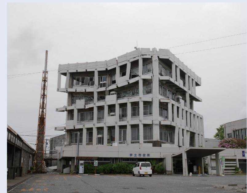
図2 半壊した宇土市役所庁舎（地震防災研究部門 山田真澄撮影）
