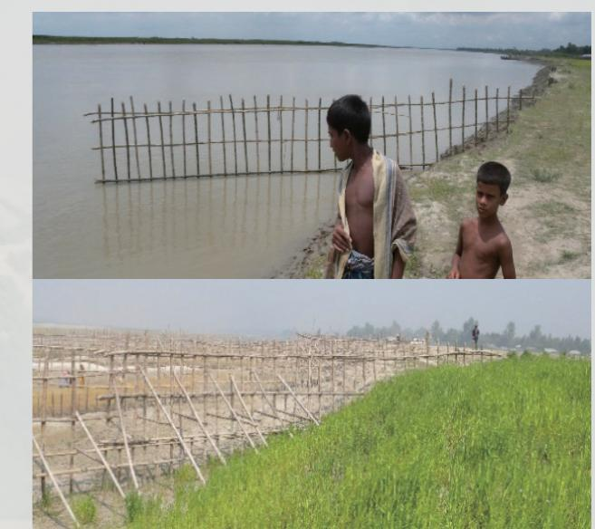
図5 上の写真：洪水前にバンダルを設置(下部の透過部分(竹製)のみ完成。上部の不透過のフェンス部分は未設置)。下の写真：洪水発生1年後に形成された河岸付近の土砂堆積部分が麦畑に変身。再生された土地が自分の土地であることをアピール。
