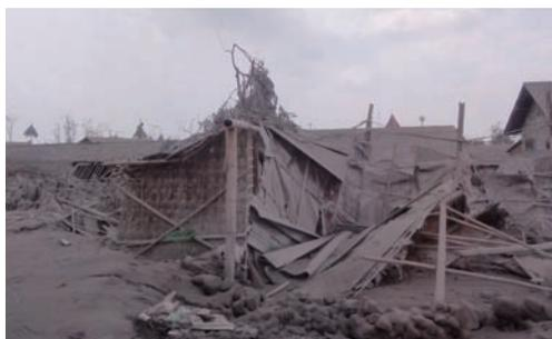
写真4 火山灰の堆積により崩壊した住宅
