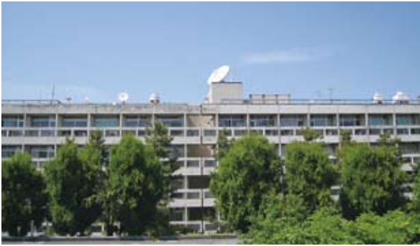
写真1 防災研新棟屋上の受信アンテナ
