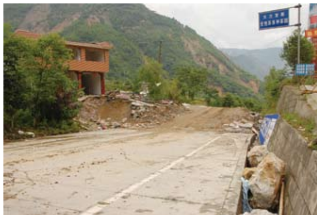
写真4 北川県庁所在地の入り口で露出した活動断層面
