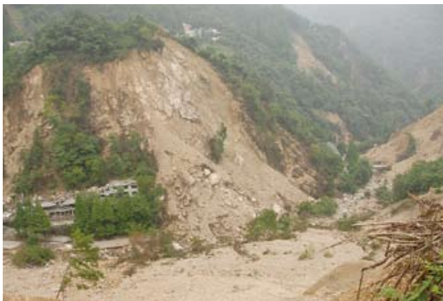
写真1 青城後山における古い地すべりダム崩壊地での斜面災害
