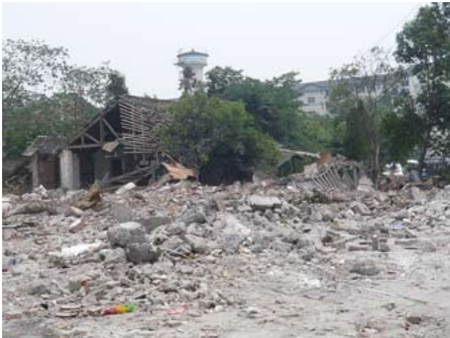
写真1 倒壊した家屋（前方）と比較的軽微な被害で済んだ集合住宅（後方）
