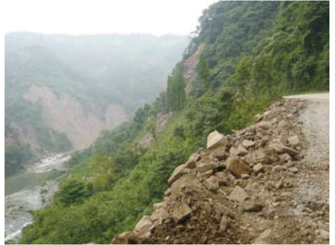
写真2 山岳地帯へのアクセス路の状況と対岸の大規模な土砂崩れ
