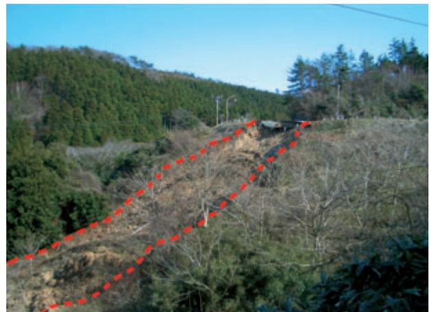
写真2 国道249号志賀町深谷地区での盛土崩壊現場
