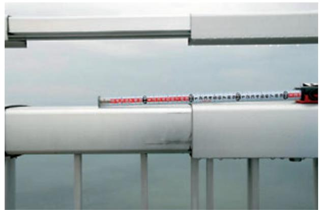
写真1 中能登農道橋の橋軸方向の振動痕
