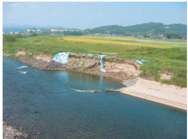
写真2 河川堤防の被災(堤防の堤外側が崩壊している)
