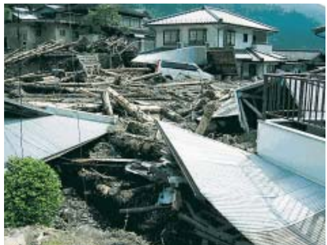
写真4 上那賀町白石地区で発生した土石流で押しつぶされた民家。多数の家屋が被害を受けたにもかかわらず、住民の自主避難により一人の犠牲者も出さずに済んだ。土石流には、多量の流木が混入している。
