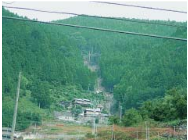
写真3 上那賀町白石地区で発生した斜面崩壊。今回の災害では、最も民家が集中している場所で発生した。
