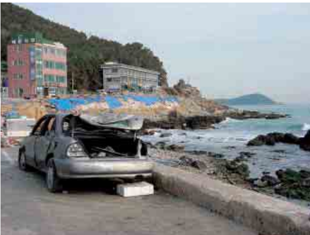
写真3 修復中の海岸道路
