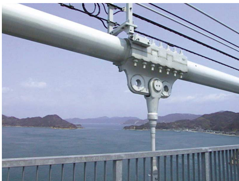
写真1 西瀬戸自動車道(しまなみ海道)の最も四国よりの橋である来島海峡大橋の大島側の吊り橋のセンターステイが破断(撮影・本田利器)
