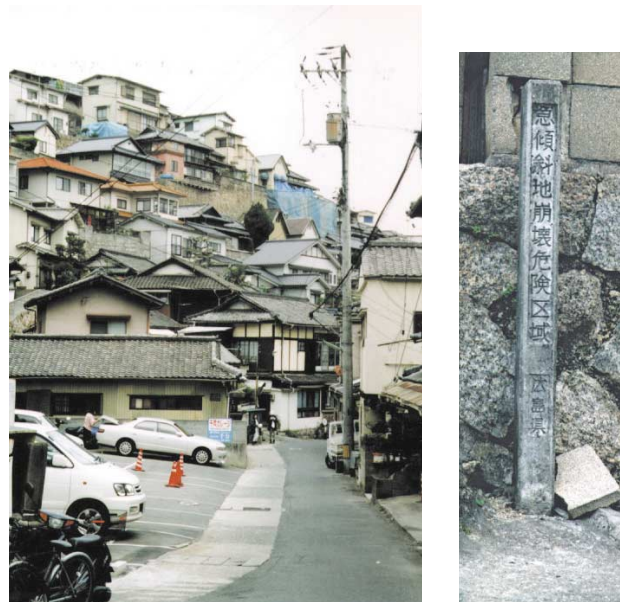
写真4 呉市の急傾斜地崩壊危険区域の被害
