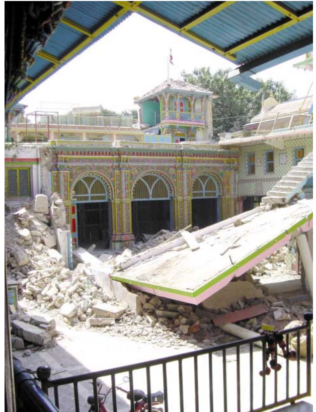
4 . 被災したBhujの寺院
