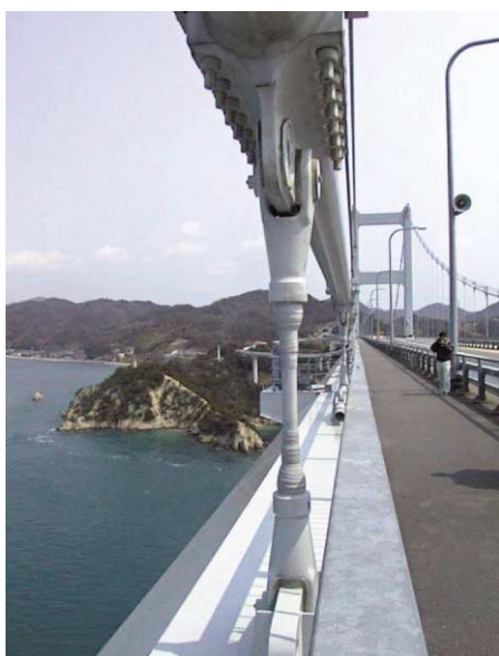
写真1 西瀬戸自動車道(しまなみ海道)の最も四国よりの橋である来島海峡大橋の大島側の吊り橋のセンターステイが破断(撮影・本田利器)
