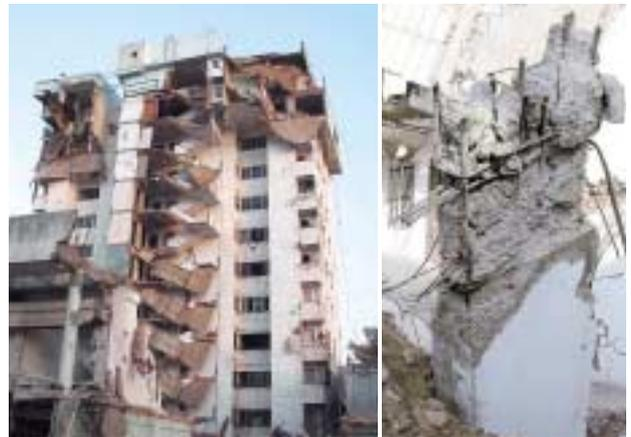
Ahmedabadで倒壊した高層アパートの1階柱（右）と同タイプの建物（左）（工学院大学 久田嘉章撮影）
