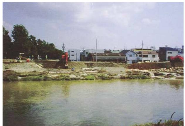
写真-2 名古屋市西区あし原町。新川左岸破堤箇所の復旧作業状況。2000/09/13。
