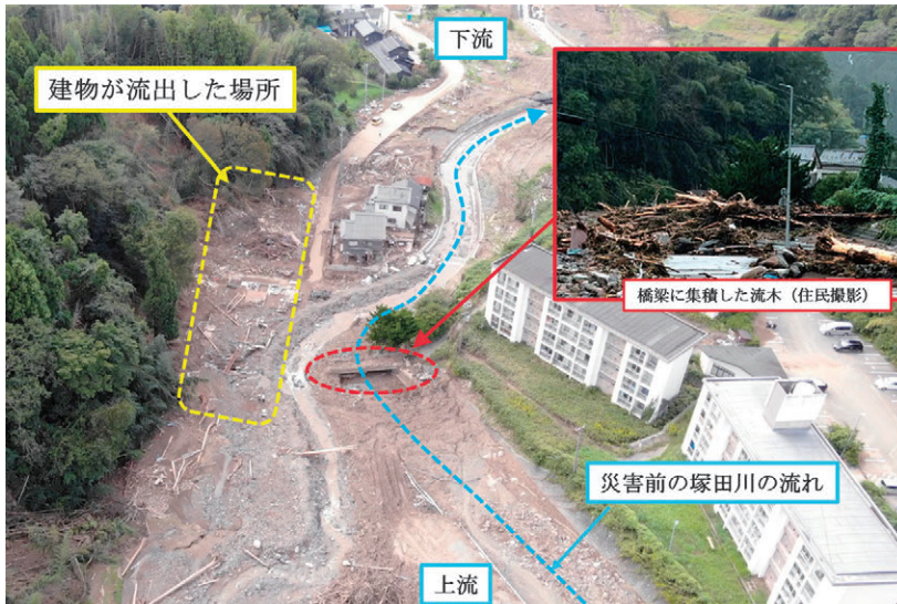
図1 塚田川河口から約1.4km上流の建物流出地区の様子
