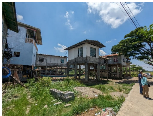
図:フィリピン農村部の浸水常襲地帯における高床式住居
