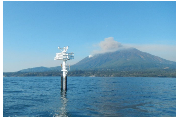
海底地盤変動観測装置
