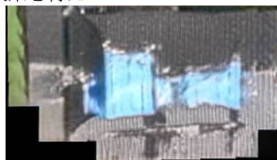
深層学習で生成した建物被害の合成データの例
