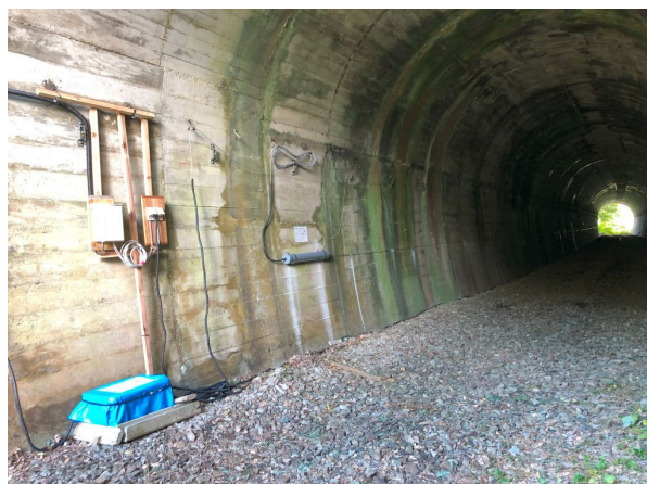
春日トンネル内での観測
