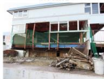
本牧海づり施設管理棟②
