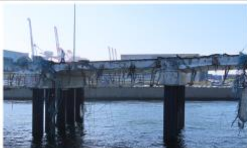
PC床版橋桁部分
