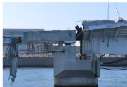
PC床版橋桁と箱桁橋の接合部分②
