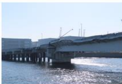
PC床版橋桁と箱桁橋の接合部分①
