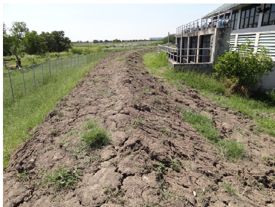
(a) 嵩上げされた土堤
