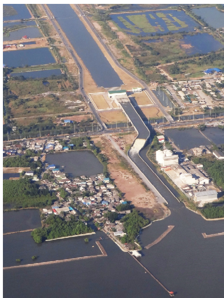
(a) 高架型の排水路
