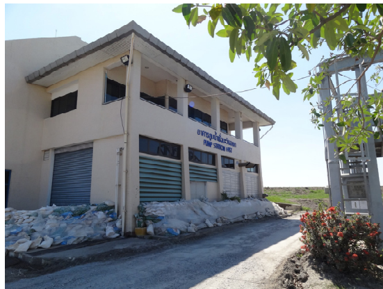
(b) 南東のポンプステーション
