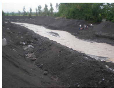
Photo 9(d) Collapse type 4
