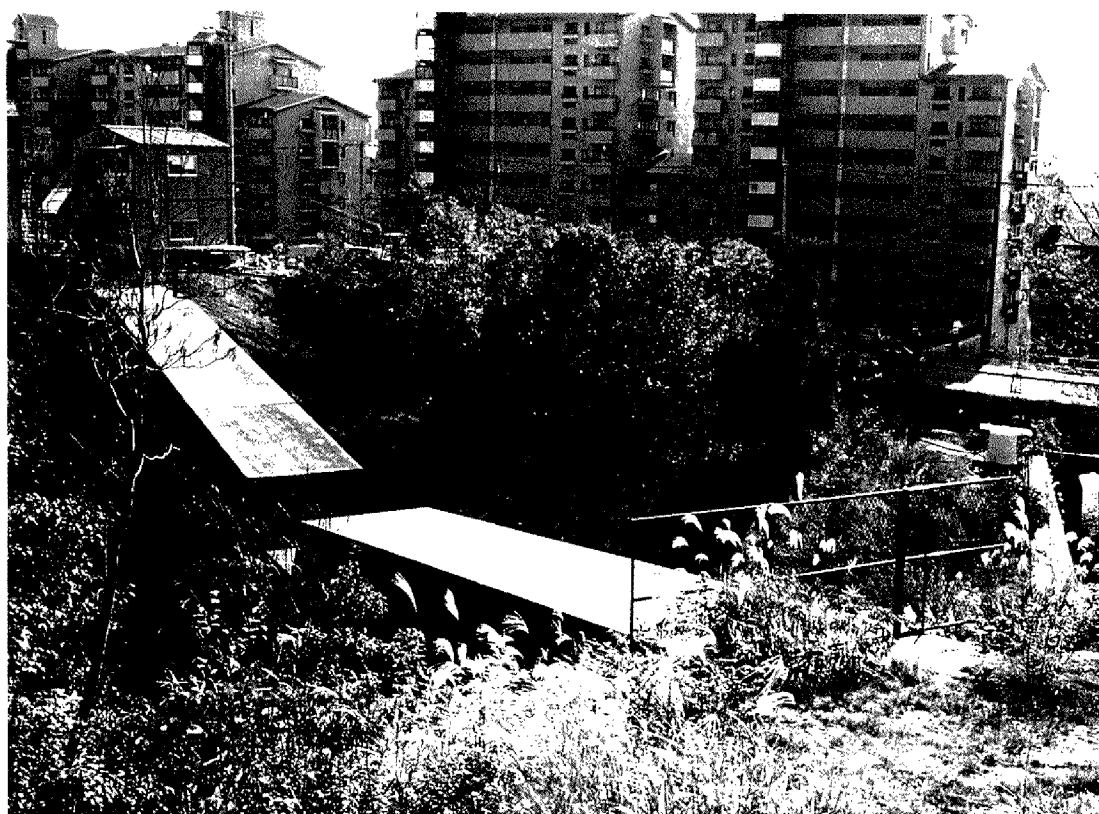
如意谷砂防ダム工（姫面市）
