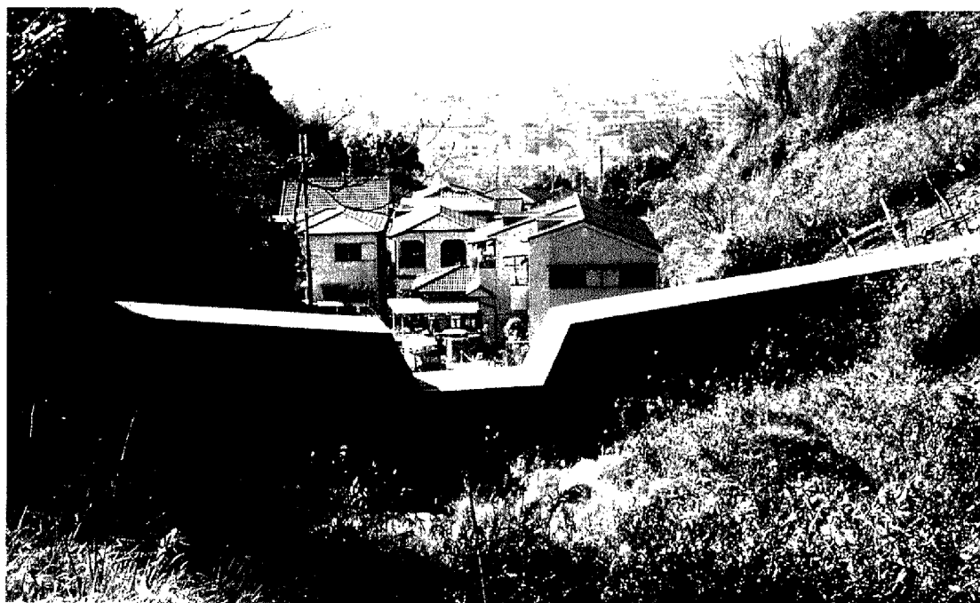
谷山溪砂防ダム工（柏原市）
