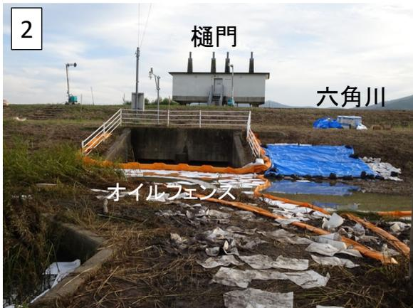
写真3 佐賀鉄工所から流出した油の吸着マットによる撤去 (1)，樋門の閉鎖とオイルフェンスの設置による六角川への油の流入防止 (2) (2019年9月2日撮影)
