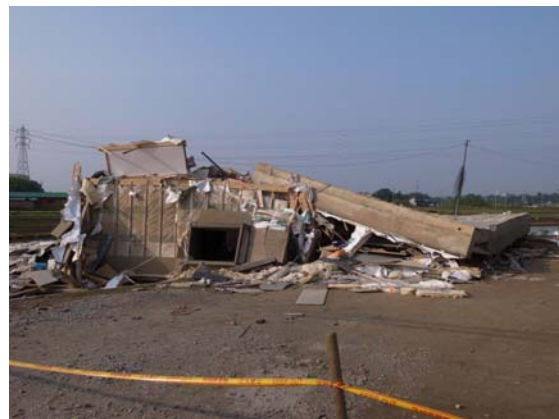
コンクリートのべた基礎ごと持ち上げられ倒壊。 上物部分がそのまま逆さになっている。
