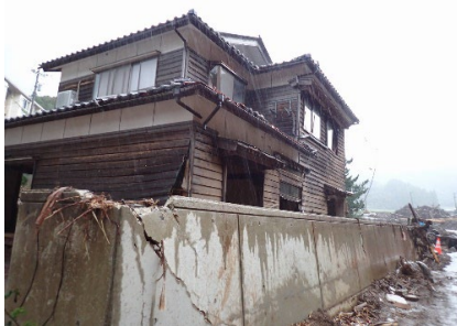
図 1 2024 年奥能登豪雨の塚田川の氾濫で被災した輪島市久手川町堂山地区 D (左)。2 棟の古い木造家屋は残存しており、上流側の RC 造の塀により流失を逃れていた (右)。
