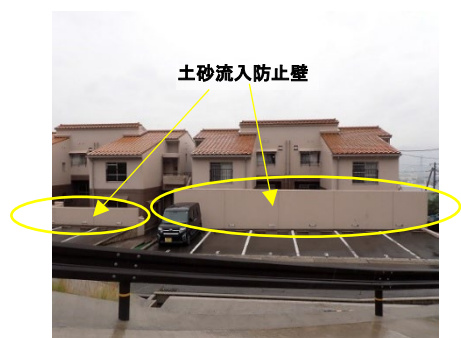
図 6 2018 年豪雨の土石流災害から修復し、土砂流入防止壁 (黄色 枠) を設置した県営緑丘住宅
