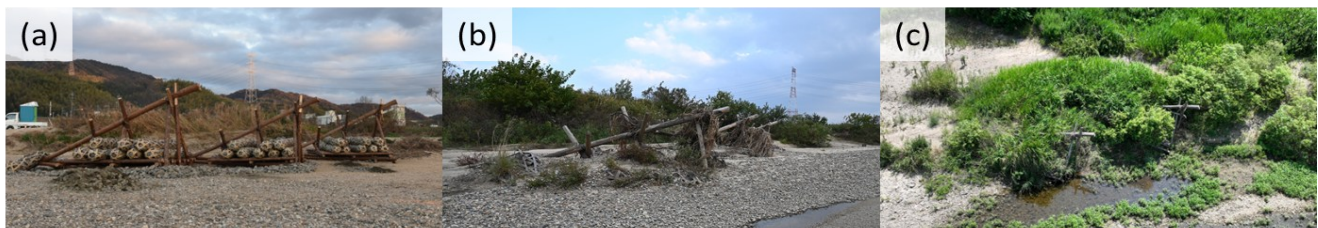
図2 伝統的河川工法「聖牛」群近傍の変化 (a)設置直後、(b)周辺に土砂が堆積、(c)微高地に植生が侵入
