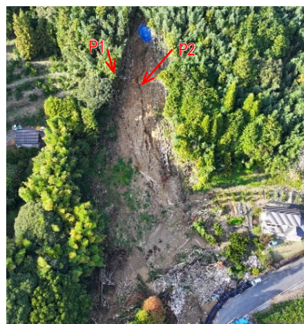
写真 1: 蒲郡市の斜面崩壊 (R6 年 11 月 30 日に撮影). P1, P2: 側壁及びすべり面における断面トレンチ
