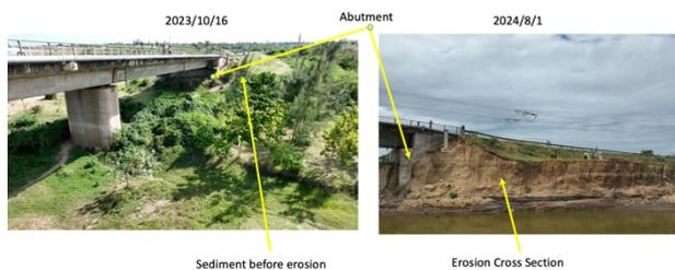
図-2 A橋の被害状況
