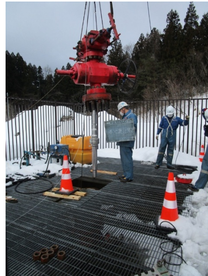
図3. 深部地震動観測井へ光センサボアホール筐体の設置風景。
