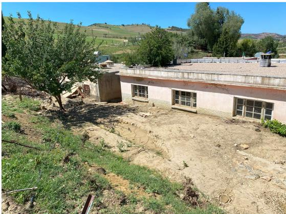
図3 mud flow の被害を受けた建物
