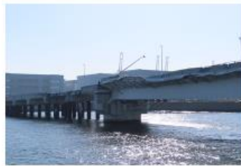
PC栈橋と箱桁橋の接合部分①
