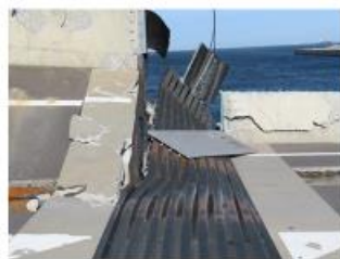
PC栈橋と箱桁橋の接合部分
