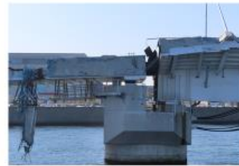
PC栈橋と箱桁橋の接合部分②
