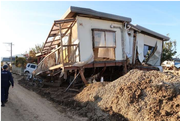
(b) 1階部分が破損した家屋
