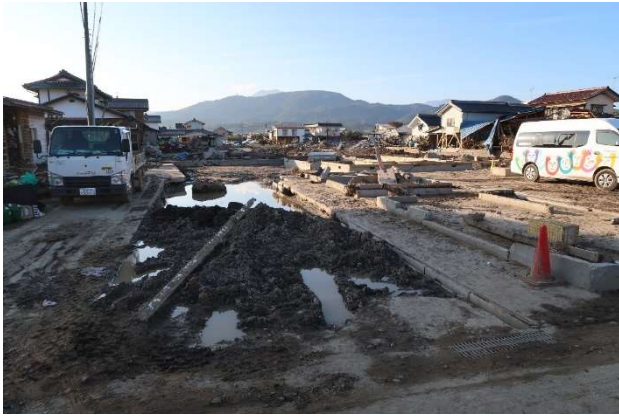
(a) 基礎部分のみを残して建物が流失した跡
