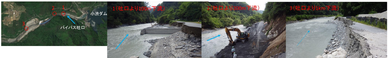
図1 小渋ダムにおける2018年7月出水における道路被災
