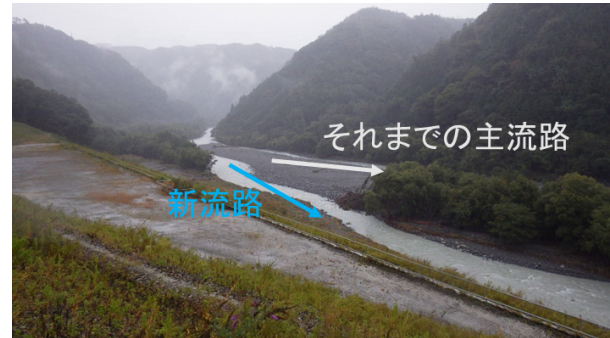
図2 9月出水による氾濫原浸食と新流路形成
