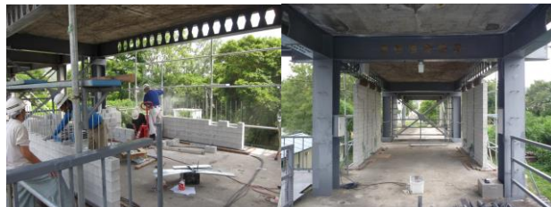
[Fig. 7] 設置作業状況 [Fig. 8] 完成状況(内観)
