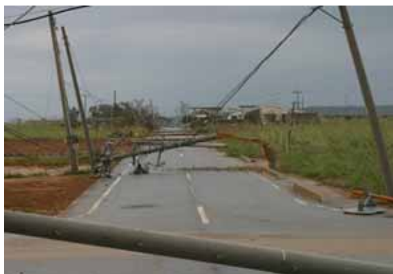
写真3 電柱の倒壊
