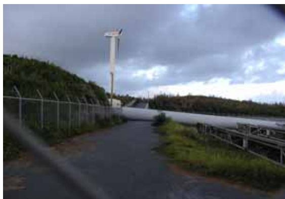
写真1 風力発電用風車の破損と倒壊
