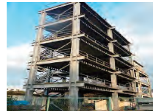
A-3鋼構造実大試験架構
