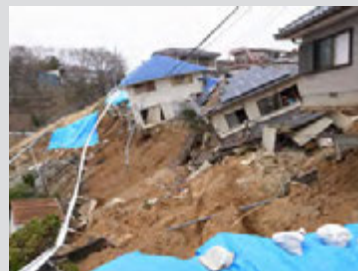
2011年東北地方太平洋沖地震 によって発生した地すべりと住 宅の被害
