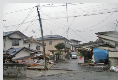
2016年熊本地震による建物被害
