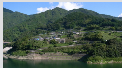
四国山地における典型的な地すべり(地震計による観測斜面)
