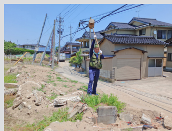
2024年能登半島地震において液状化した住宅地における地盤調査
